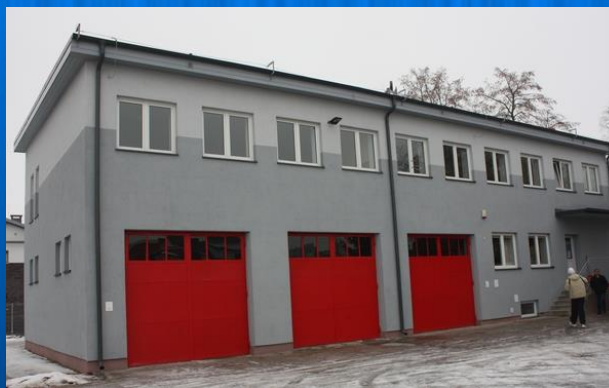
Remiza OSP w Brusach po modernizacji
