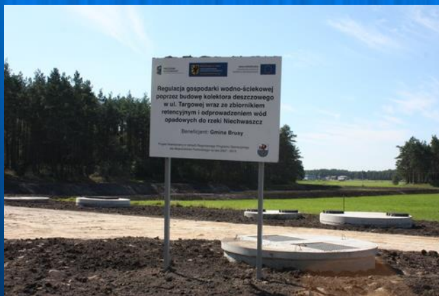
Widok na zbiornik retencyjny
