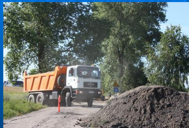
Prace na trasie Brusy – Brusy Wyb.
