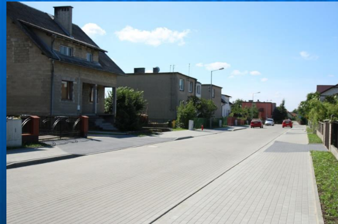
Ulica Konarskiego w Brusach.
