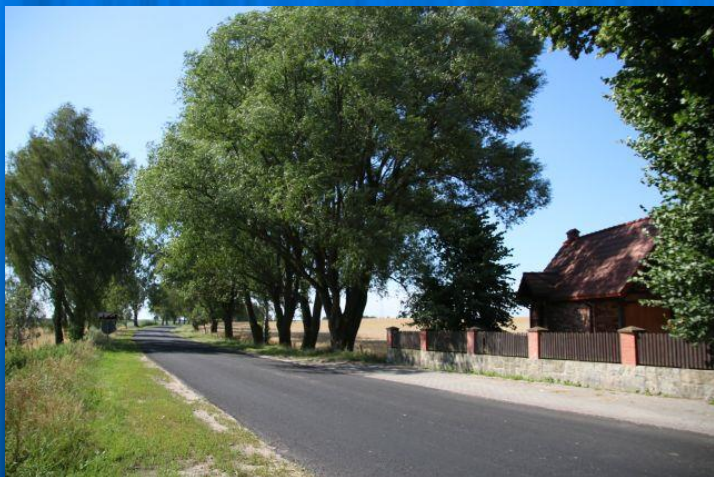
Nowa nawierzchnia na drodze powiatowej z Kosobud w kierunku Czerska
