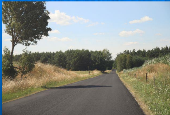
Nowa nawierzchnia na drodze powiatowej z Czapiewic w kierunku Leśna
